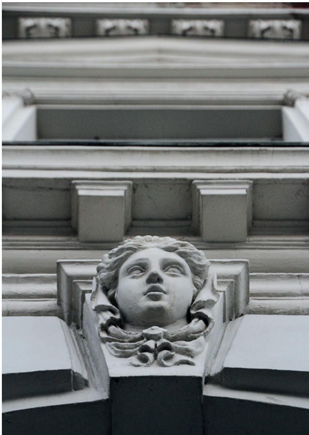
Naslovnica: Pročelje palače na Nemčičevu trgu 8, pogled odozdo
